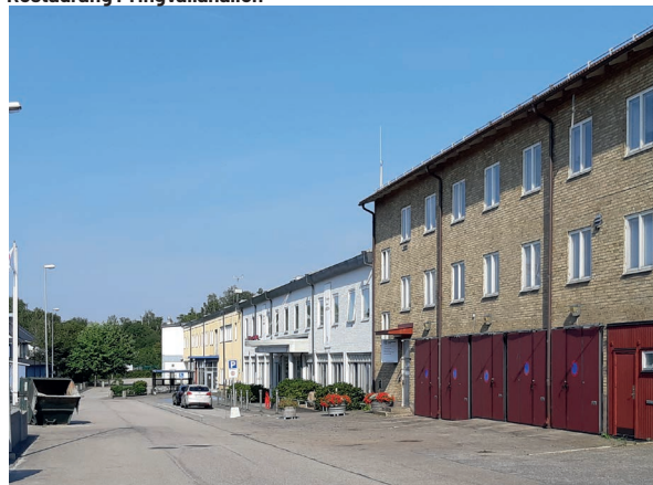
Trollhättan Energi AB huvudkontor längs Förrådsgatan
