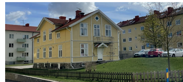
Lodjuret 7, byggt som veterinärbostad, senare vandrarhem.
