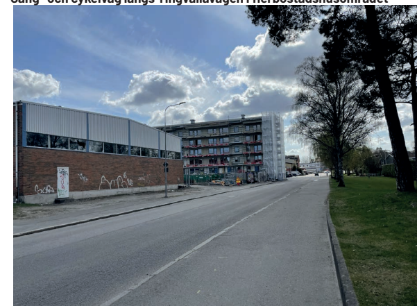
Gång- och cykelväg längs Tingvallavägen vid kvarteret Zebran som byggs ut
