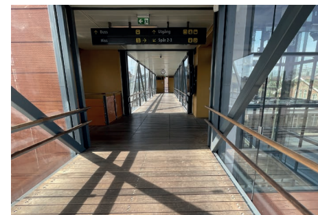
1. Gångbro över järnväg
