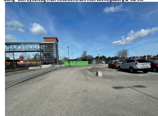
Bron över järnvägen och del av pendelparkeringen i norra stationsområdet
