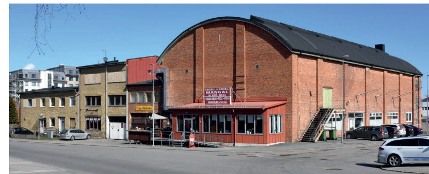
Glassfabriken inom Geten 13 och Tingvallahallen inom Geten 11 Foto: Kulturbyggnadsbyrån, 2022
